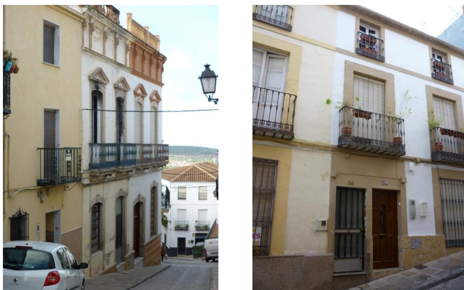
Ejemplos de división vertical de inmuebles en calle Dolores Torres
