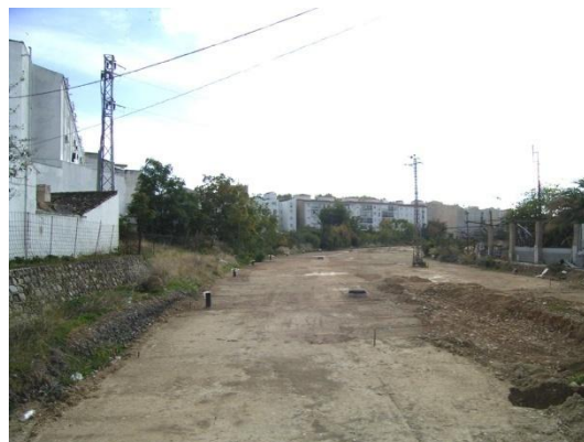
Urbanización en UE-21 en ejecución. Vía verde
