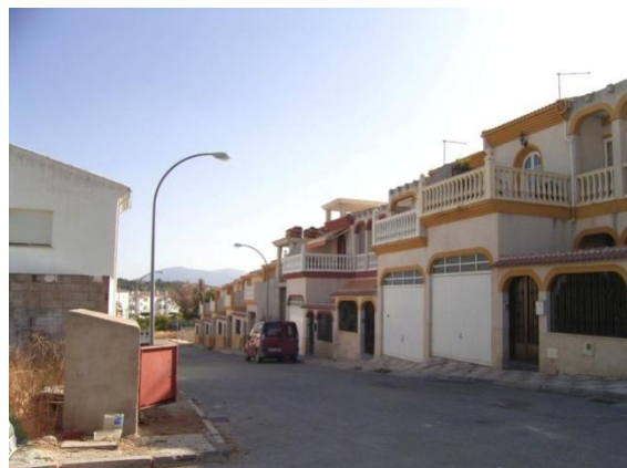
Trama contemporánea unifamiliar
