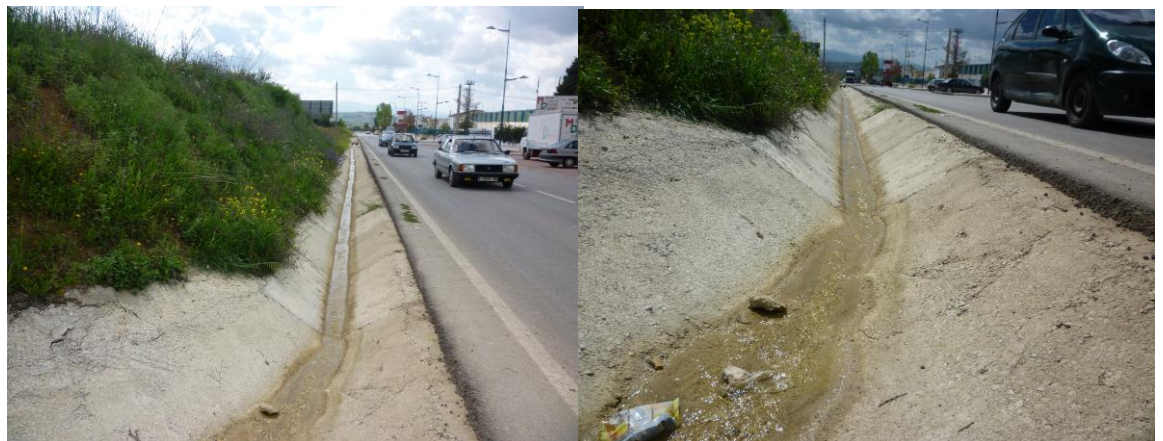
Ilustración 14.- Aspecto actual de la cuneta. Se encuentra en buen estado y dispone de pendiente suficiente (2%)
