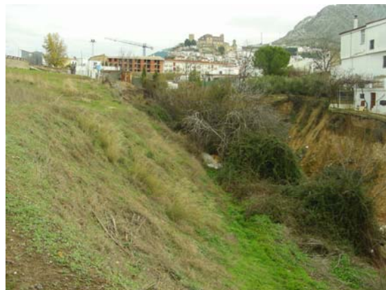
Ilustración 3. Aspecto de las márgenes del arroyo Fuente de la Villa
