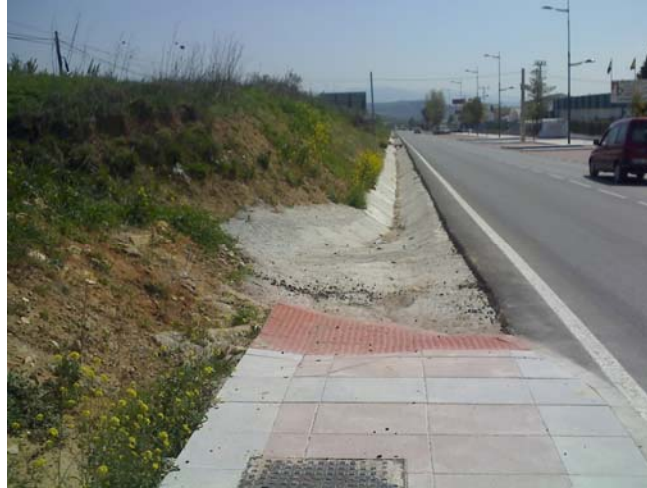
Ilustración 13. Desembocadura del Arroyo Larija a la cuneta de la JA-3305
