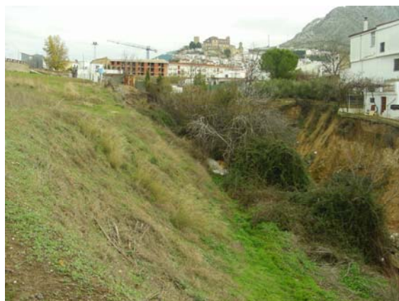
Ilustración 4. Aspecto de las márgenes del arroyo Fuente de la Villa
